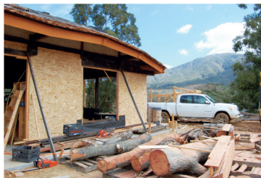
足りない木材にはアメリカ製建材も使用
